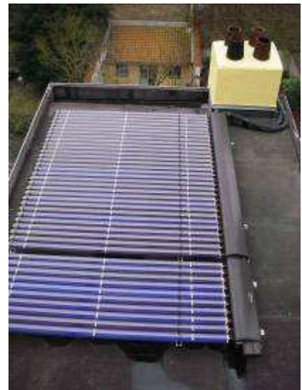
Figuur 1 : vacuümbuiscollectoren
